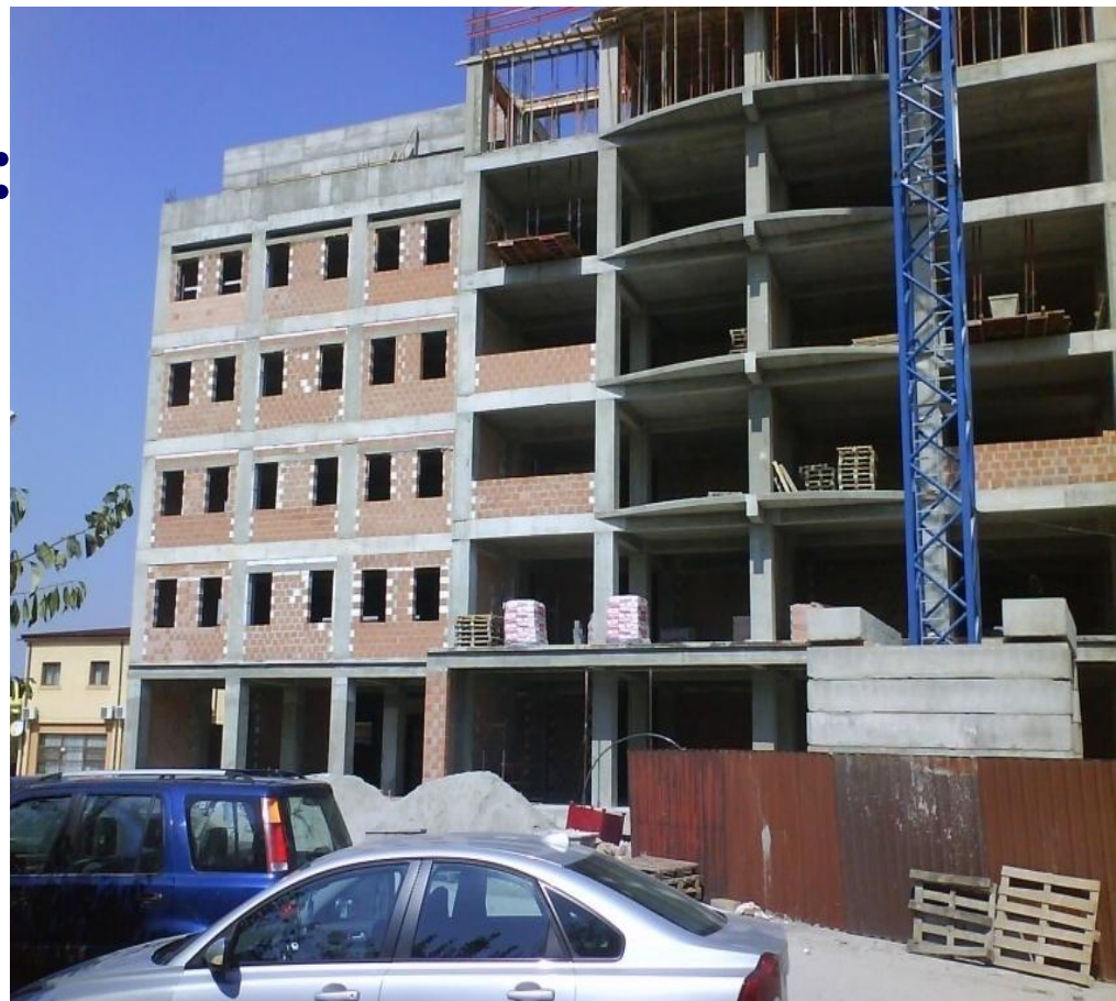
Extinderea Hotelului CRISS Bucuresti
